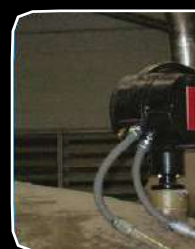
Μέτρηση στάθμης αλατιού στο πάτο δεξαμενής άλμης.
