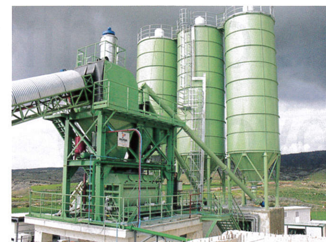
Πύργος ανάμειξης του παρασκευαστηρίου σκυροδέματος PROTEM.
